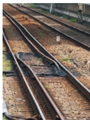
六浦駅付近の3線軌条。ホーム部分のみ、共有レールが外側になり、内側のレールも左右逆になっている。
